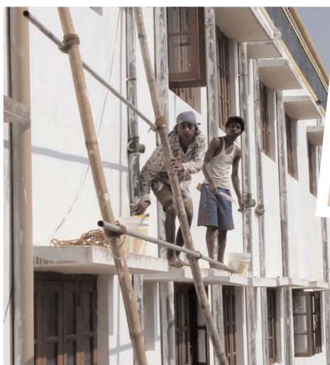
les peintres indiens et leur échafaudage high-tech
